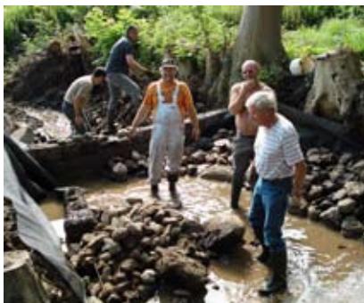
Mændene knokler i mudder og vand for at få lagt stenene på den rigtige måde.
